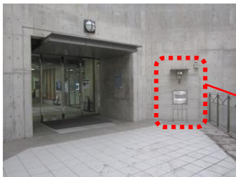
【図書館 3F 自動扉の外側】
